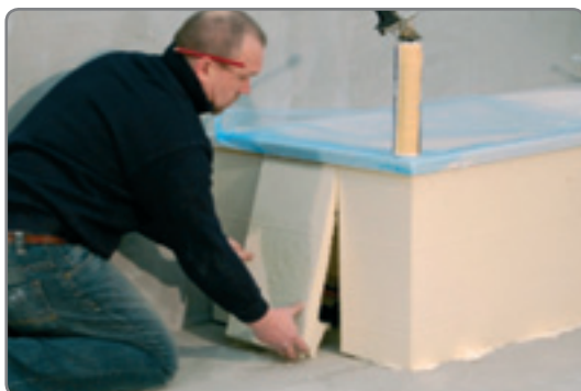
Problemzonen bei herkömmlichen Systemen: Hohlraum zwischen Träger und Wanne
